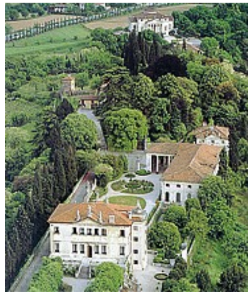
Capolavori Sopra, villa Valmarana ai Nani e, sullo sfondo, La Rotonda. A destra, alcune delle crepe della villa
