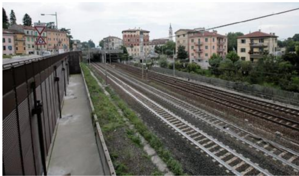
I binari in zona tribunale e sullo sfondo piazzale Fraccon: è la zona di maggiore criticità per il traffico
